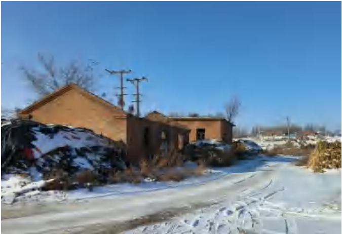
南侧闲置房屋
