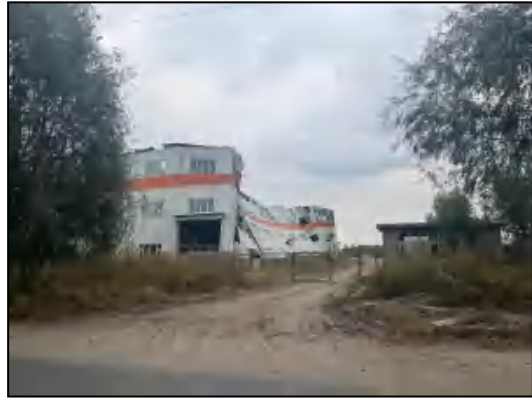
厂区南侧隔西坡路 15m 为闲置厂房
