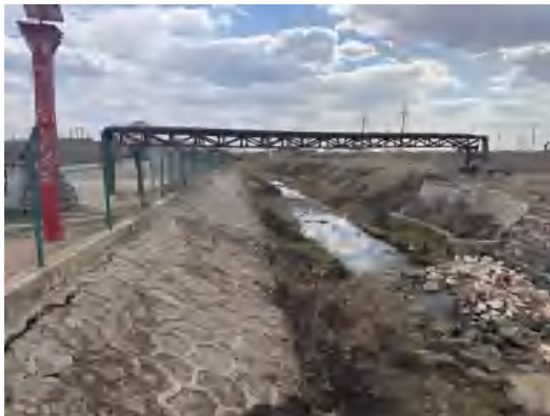
图 4-1 穿越处河道现状照片
