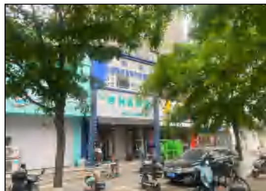
北侧紧邻食品药品小区门市房及居民楼
